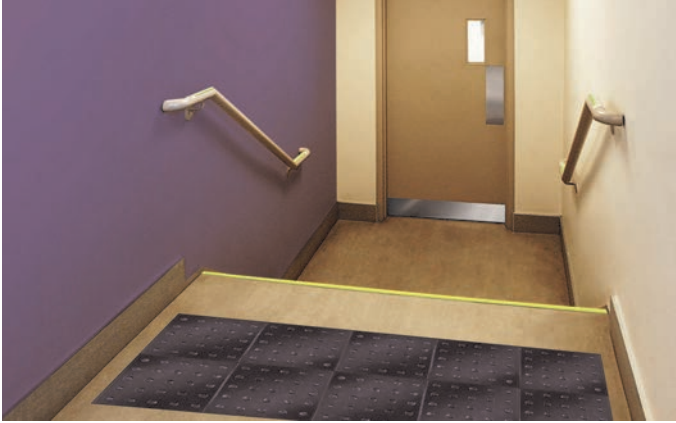
Indicateur tactile d'éveil de la vigilance à dômes tronqués
