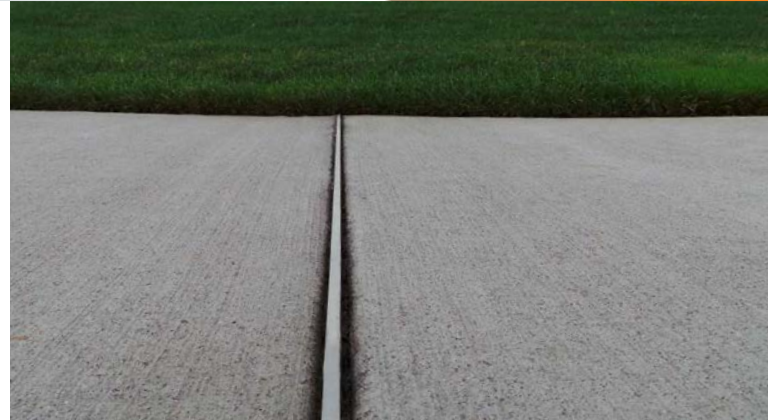
Le système de joint de trottoir TripStop MC aide à prévenir les risques de trébuchement sur les trottoirs.
