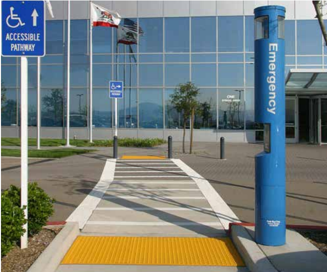
Indicateurs tactiles de surface de marche à dômes tronqués
