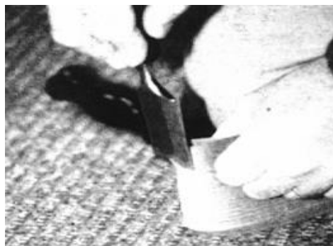
a. Pliez la plinthe en deux
